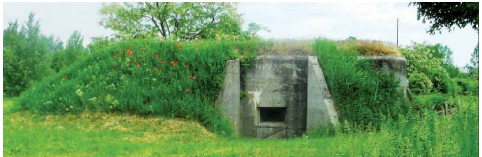
Prístupný atypický Šnejdárkov objekt ťažkého opevnenia B-S 6 v Petržalke.
