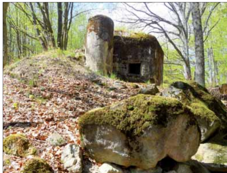
Objekt ľahkého opevnenia nového vzoru (vz. 37) - ropík K-V 220 A-180 s bočnými paľbami v Slanskej Hute.
