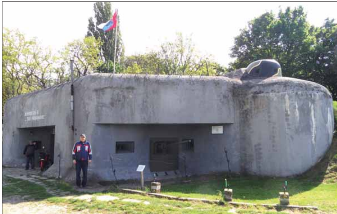
Pristupný obojstranný objekt ťažkého opevnenia (zrub) B-S 8 s dvoma zvonmi a s odolnosťou II so sprievodcom Josefom Košířerom a autorom článku v Petržalke.
