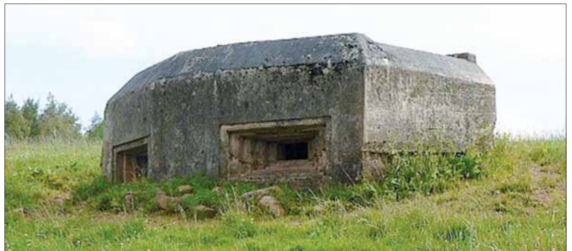
Objekt starého vzoru (vz. 36) využíval čelné palby, mal väčšie strielne, nemal úchyty pre maskovacie siete... v porovnaní s ropíkom.
