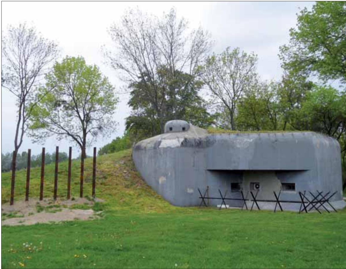
Prístupný obojstranný objekt ťažkého opevnenia B-S 4 s dvoma zvonmi s odolnosťou II a protitankovou prekážkou s oceľových ihiel v Petržalke.
